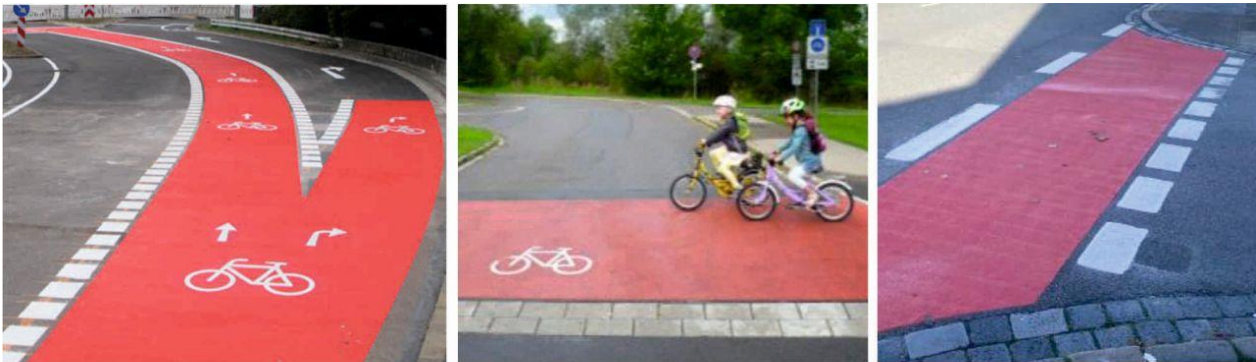
Bild 37 Beispiele eingefärbte Radfurten an Knoten / Einmündungen
