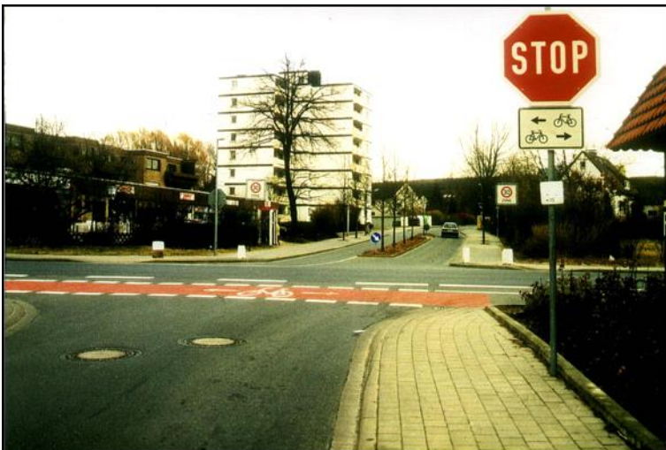
Bild 4: Sicherheitserhöhende Kennzeichnung einer Radwegfurt mit Zweirichtungsbetrieb
