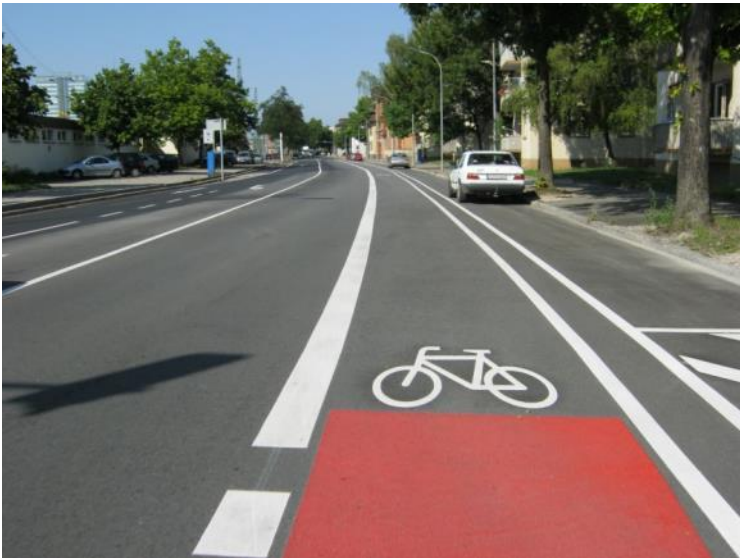
Bild 5: Radfahrstreifen mit markiertem Sicherheitstrennstreifen (Singen)
