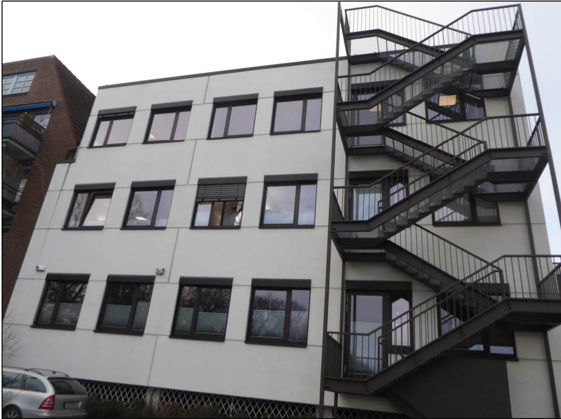
Abbildung 4: Rückseite des Gebäudes mit völlig abgedichteter Fassade (11.01.2022)
