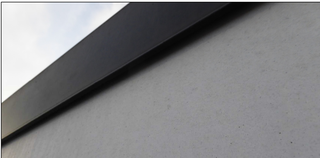
Abbildung 5: Ansicht des Dachfalzes (11.01.2022).
