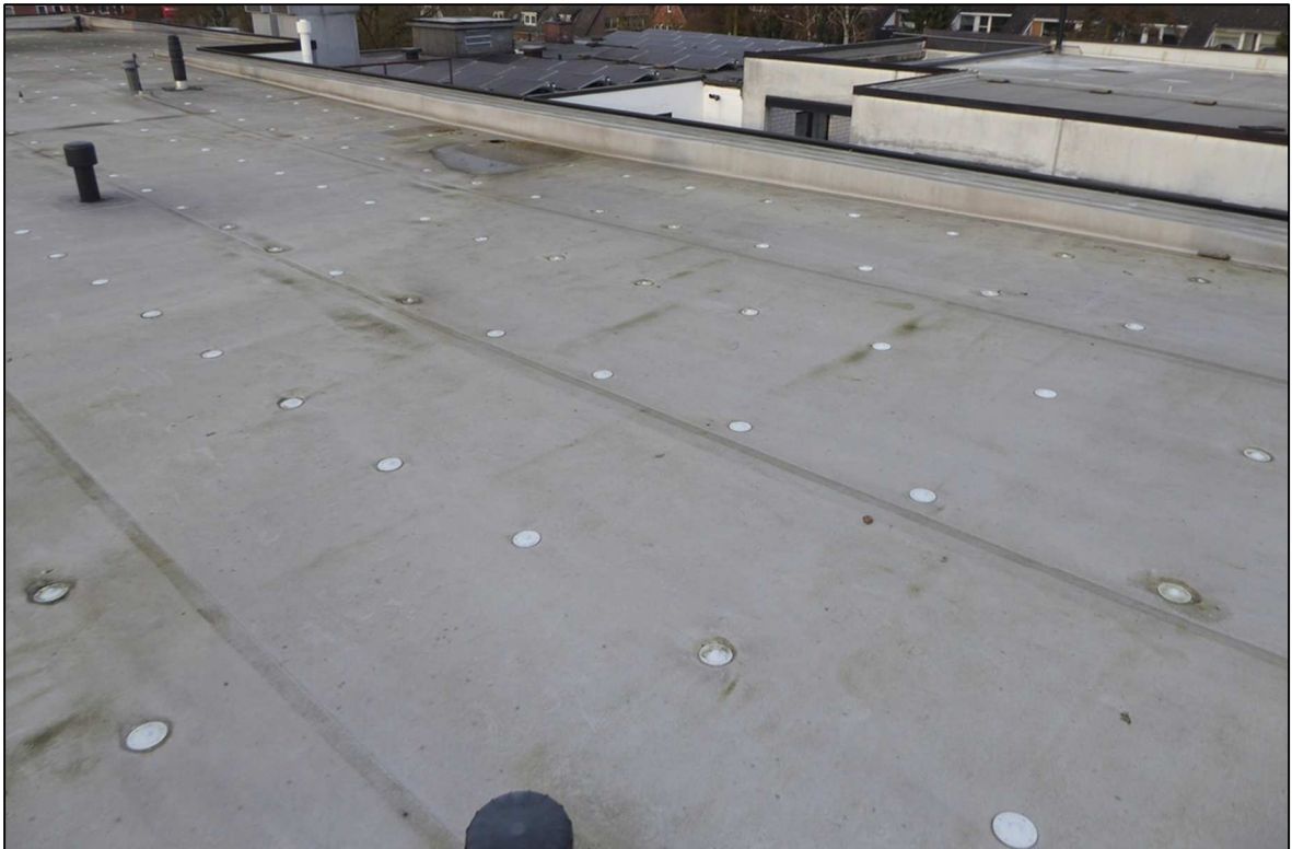
Abbildung 6: Ansicht des Daches (11.01.2022).
