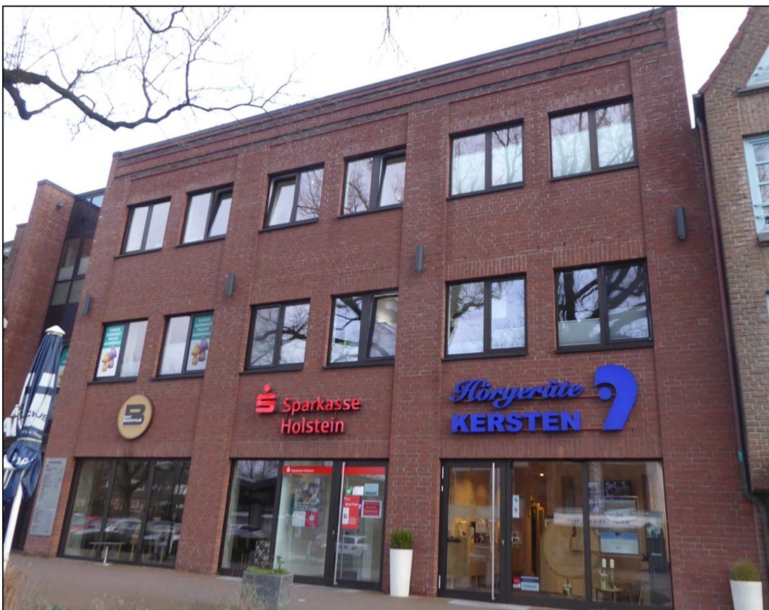
Abbildung 3: Fassade an der Straßenseite ohne Verkleidungen oder andere Spalten (11.01.2022).
